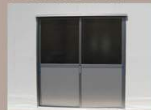
⑨ 出入口(引違いサッシ)
