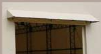
② 庇 (出入口上部)
